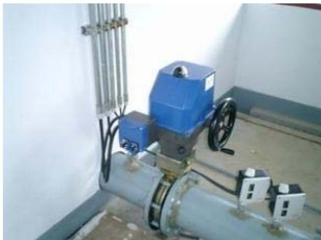
Рис. 21. Прямоходный электрический исполнительный механизм
