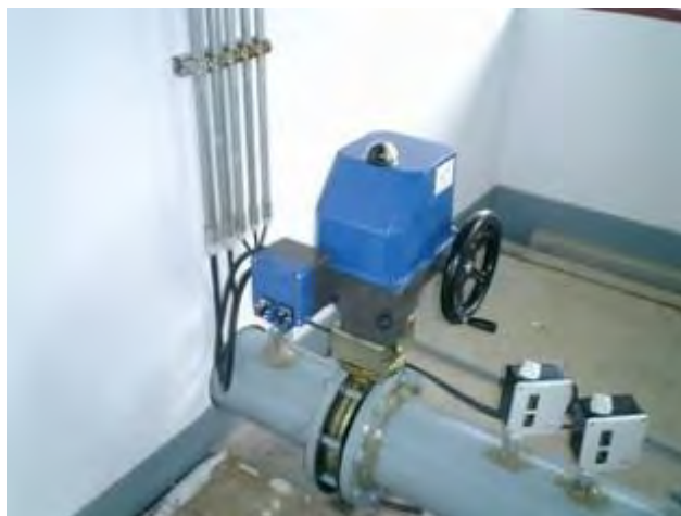
Рис. 21. Прямоходный электрический исполнительный механизм
