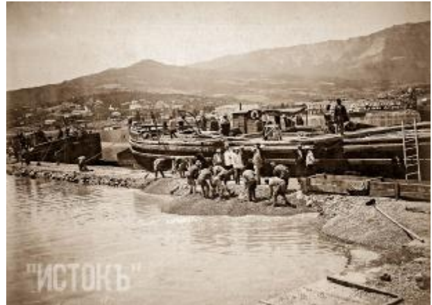
Строительство мола в Ялте
