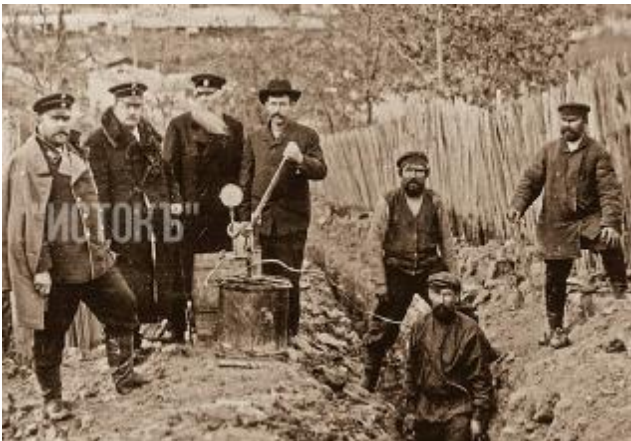
Гидротехнические испытания прокладываемого водопровода в Ялте
