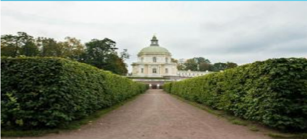
Реставрационные работы в Ораниенбауме
