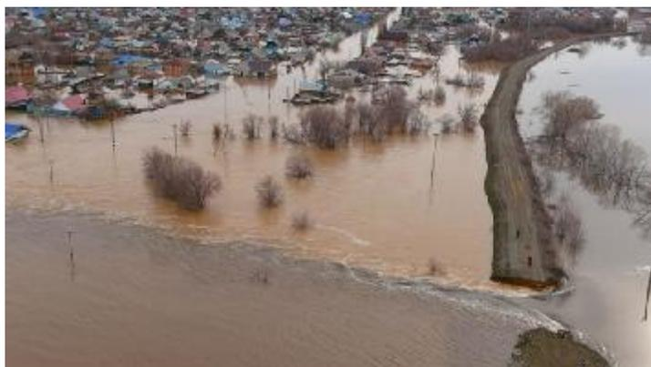
*Разрушенная защитная насыпная дамба, наводнение 2024 года в г. Орск*
